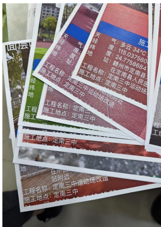
图 2 施工记录（时间信息无法核实）
